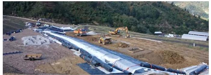
Figura 3. Vista general de trabajos de sellado en la vaguada izquierda de Artigas
